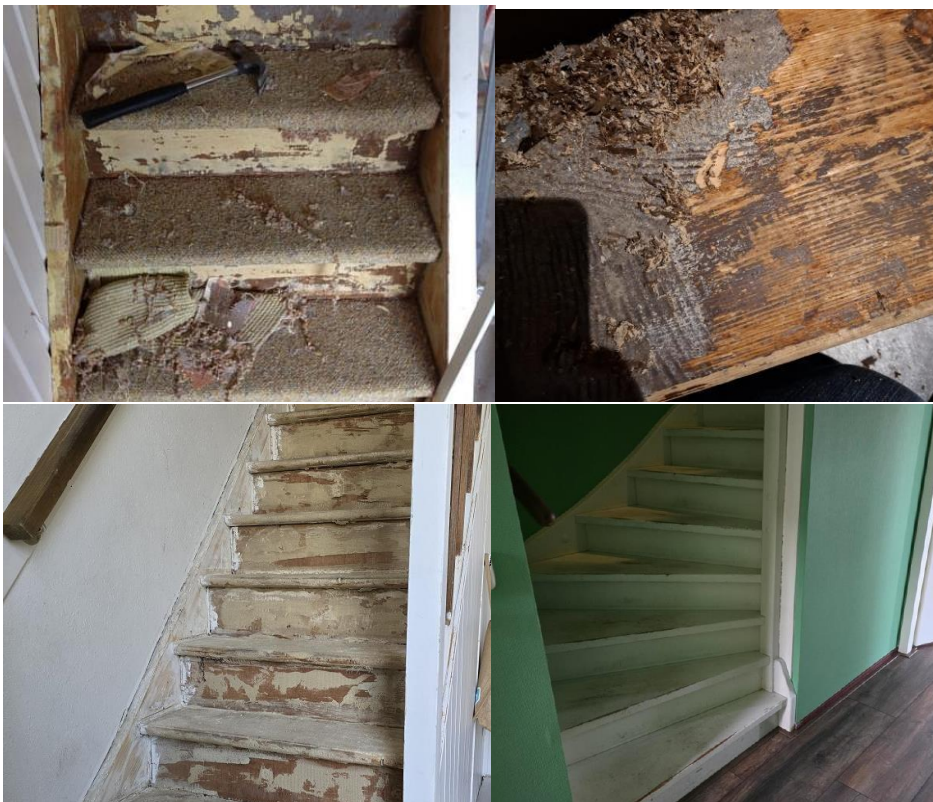
2 – Uitgesleten traptreden: De traptreden dienen volledig vlak te zijn.
